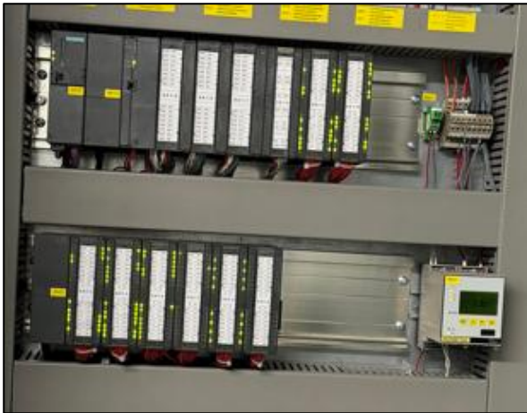
Abbildung 20: Siemens S7/300
