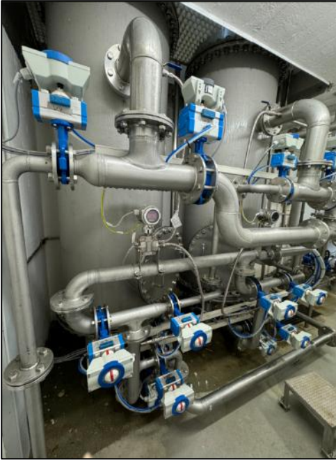
Abbildung 17: Mehrschicht- und Entsäuerungsfilter
