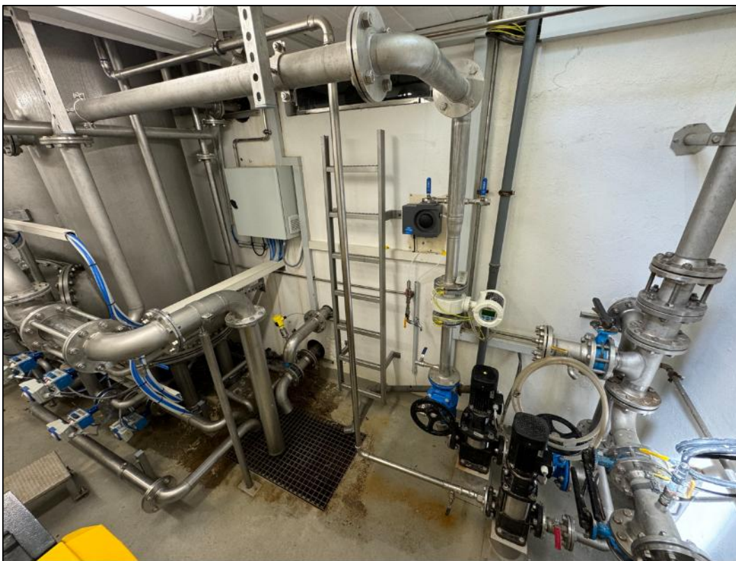
Abbildung 16: Rohrkeller vorderer Bereich
