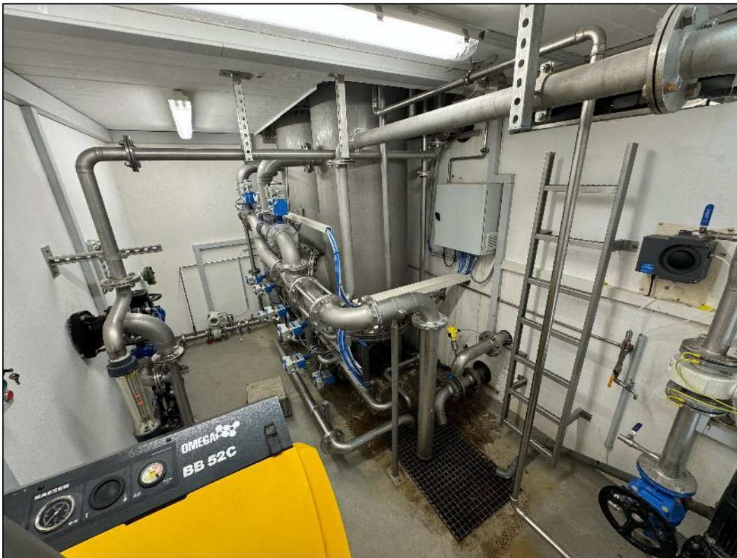
Abbildung 14: Rohrkeller hinterer Bereich
