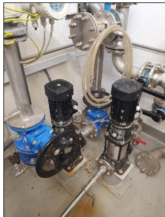
Abbildung 19: Spülwasserpumpe
