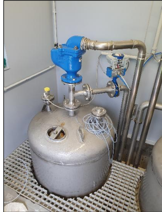
Abbildung 18: Mehrschichtfilter
