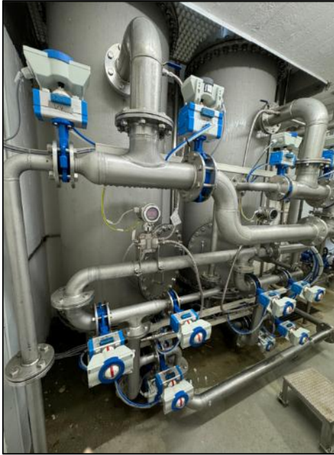
Abbildung 16: Mehrschicht- und Entsäuerungsfilter
