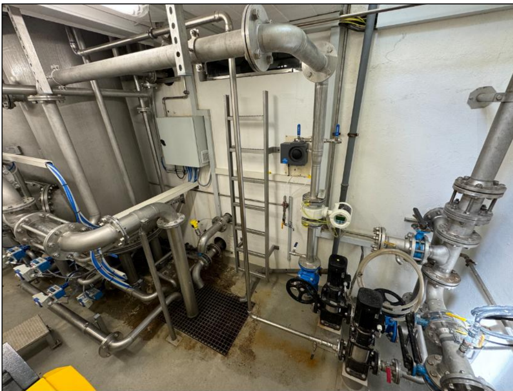
Abbildung 15: Rohrkeller vorderer Bereich
