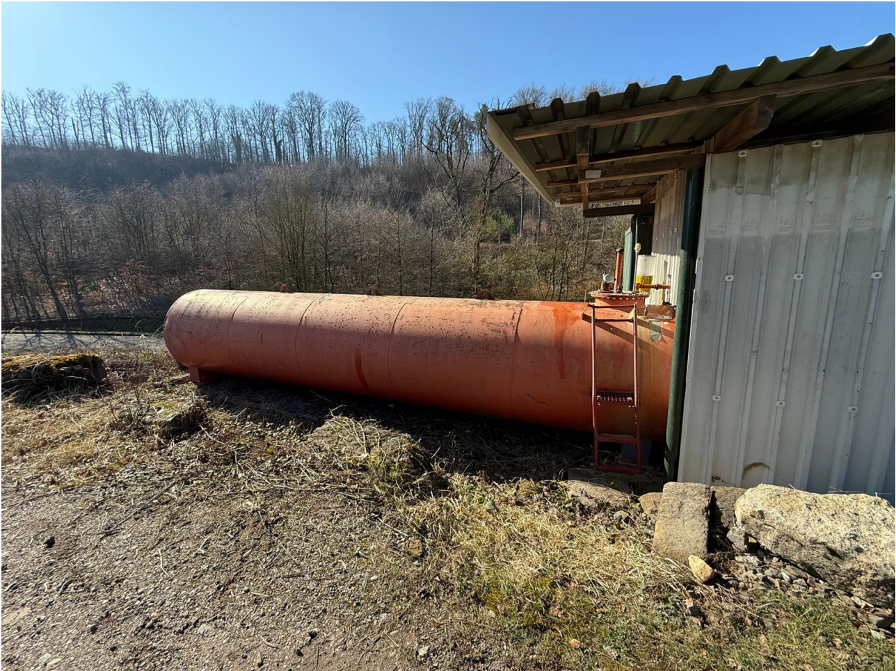
Abbildung 1: Standort Bestandstank, Hütte wird vor der Maßnahme abgerissen.
