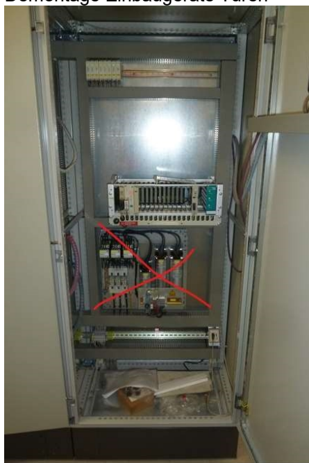
Demontage Kompensationsanlage
